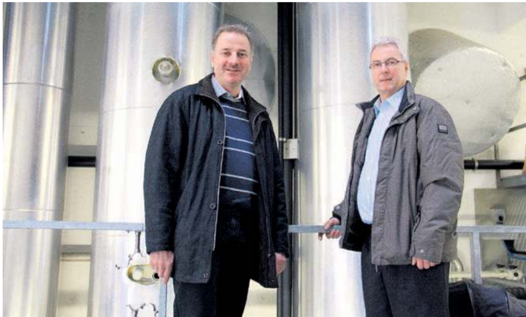
Seit 2010 liefert die Anlage in Kloten Stickstoffdünger. Peter Briner (links) und Christoph Liebi sind stolz auf die Anerkennung, die sie für die Anlage erhalten haben. Bild: bhk
